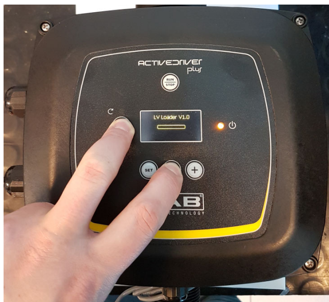
Рисунок 9В - Обновление Active Driver Plus ПО 1.X
