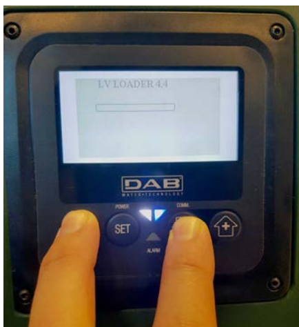
Figura 9C – Acceso al Loader para actualizar e.sybox
