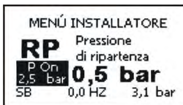
Figure 19: Configuration de la pression de redémarrage
